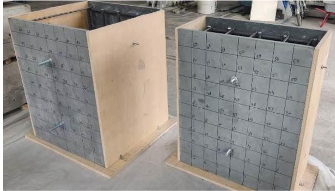
Рис. 2. Фрагменты армопалубочных блоков
