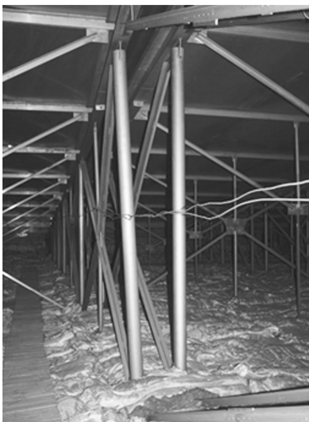
Рис. 4. Утепление в уровне нижних поясов ферм Fig. 4. Insulation at the level of the lower chords of the trusses
