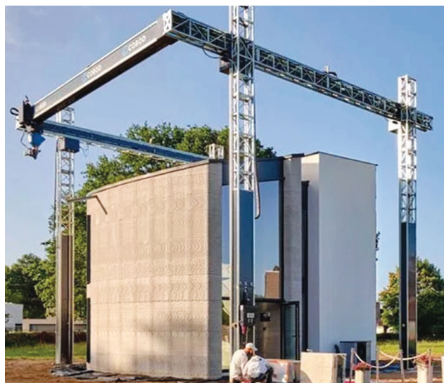
Рис. 4. Портальный строительный принтер Fig. 4. Gantry construction printer
