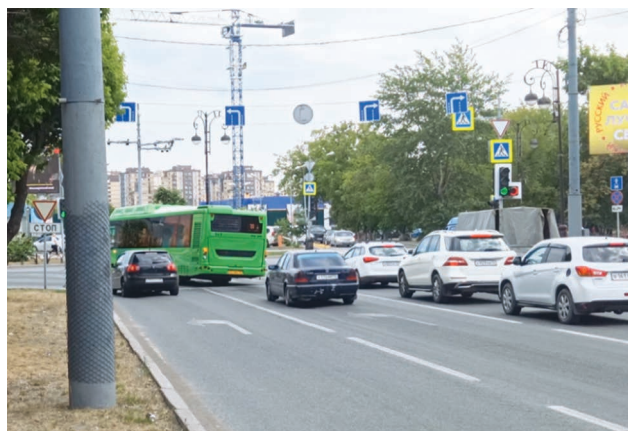
Рис. 5. Разметка 1.18, нанесенная перед перекрестком улиц М. Тореца и Республики в г. Тюмени
