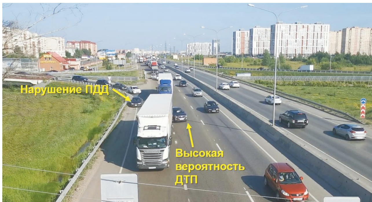
Рис. 2. Движение транспортного потока в зоне переплетения левоповоротного съезда с ул. Закалужской в сторону г. Екатеринбурга
