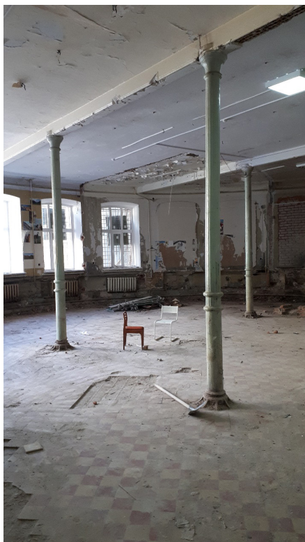
Рис. 1. Общий вид чугунных опор Fig. 1. General view of cast iron supports
