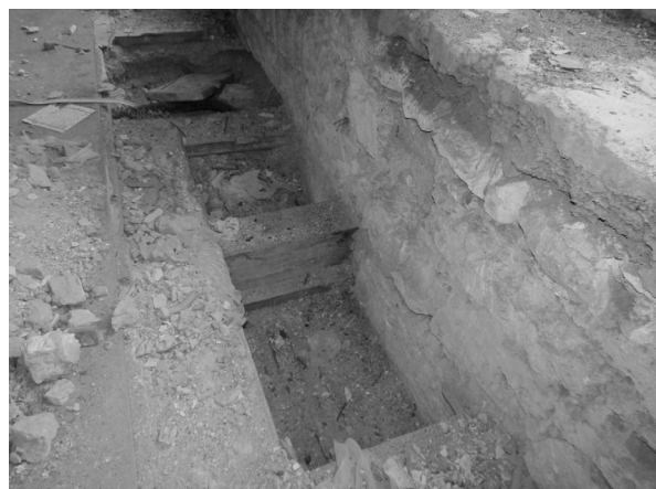
Рис. 3. Вид вскрытия перекрытия первого этажа Fig. 3. View of the opening of the first floor ceiling
