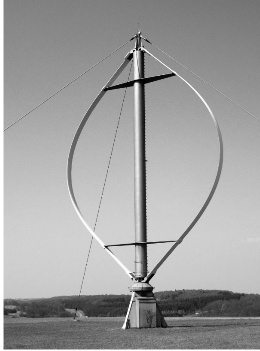
Рис. 1.1. Ветрогенератор Дарье Fig. 1.1. Wind turbine Darrieus
