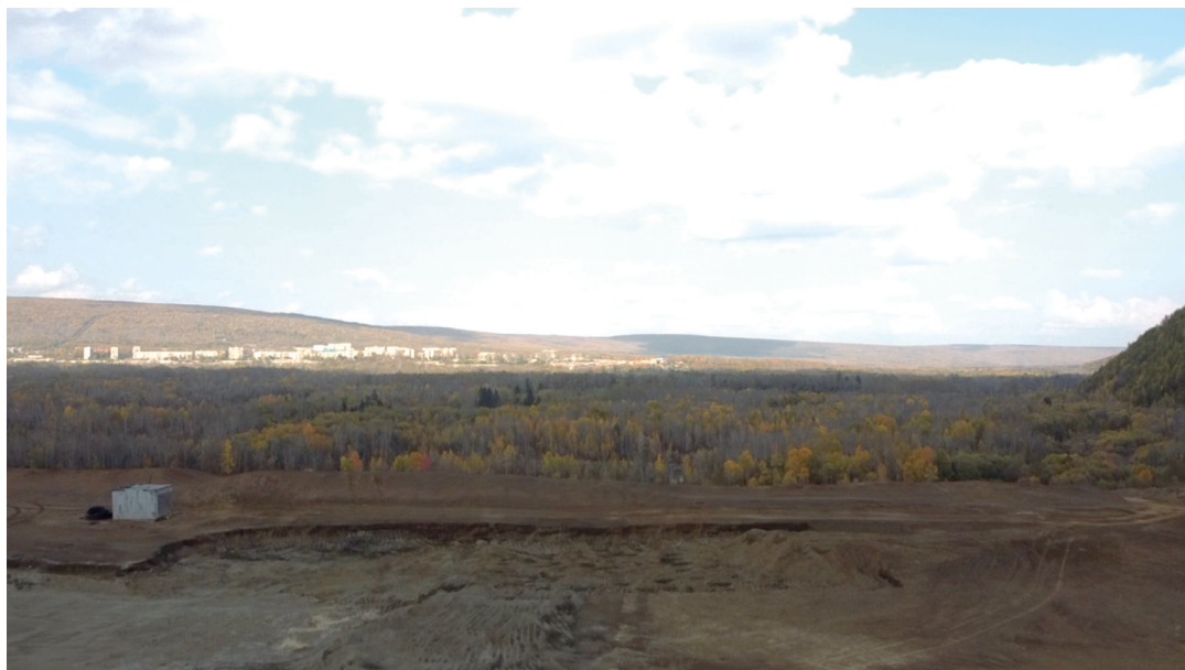
Рис. 1. Поверхность второго хвостохранилища Солнечной обогатительной фабрики
