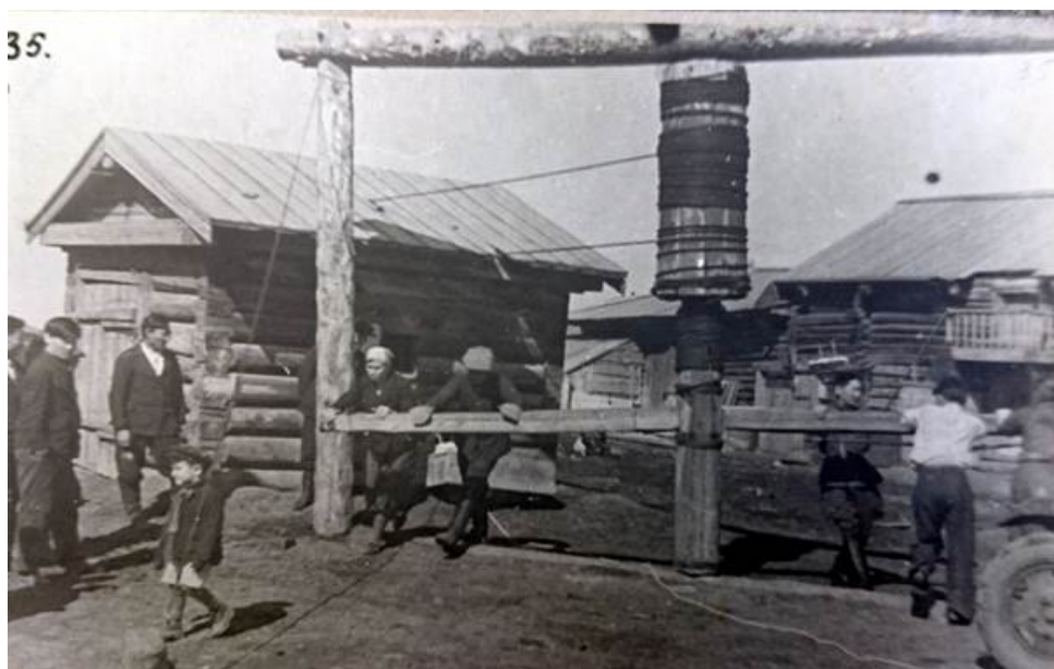
Рис. 2. Спуск клетки в шахту Шергина, г. Якутск, 1939 г. Фото П. Бороздина. РГАЭ. Ф. 82. Оп. 2. Д. 98. Л. 35.
