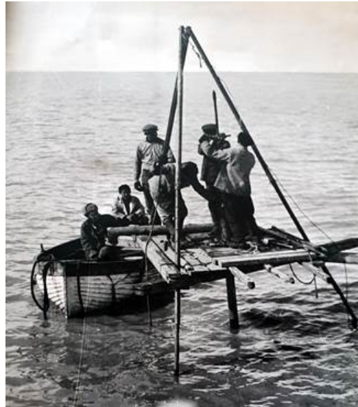
Рис. 2. Бурение скважины участниками Северной экспедиции 1962-1963 гг. Восточно-Сибирское море в районе дельты р. Индигирки, 1962 г. Фото Н.Ф. Григорьева [4, л. 12]
