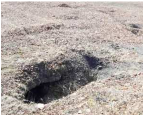
Рис. 4. Провал грунта на территории закрытой шахты Печорского угольного бассейна
