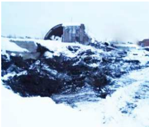
Рис. 5. Провал грунта на территории шахты Юнь-Яга
