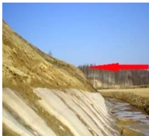
Рис. 6. Бугор пучения на поверхности насыпи [9]
