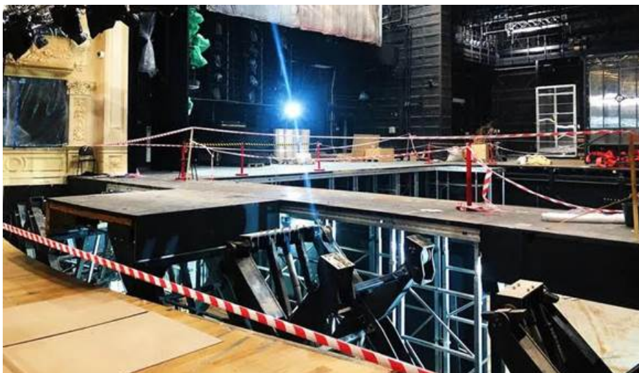
Рис. 3 Монтаж плунжеров (подъемно-опускных площадок) Основной сцены БДТ. 2013 год.
