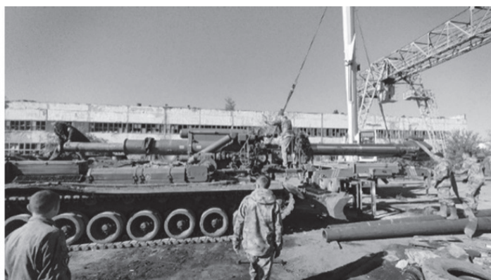
Рис. 4. Организация замены ствольно-затворной группы на изделиях АВ
