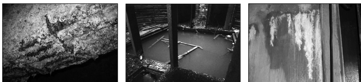
Рис. 2. Результат действия различных агрессивных компонентов окружающей среды на элементы подземных сооружений
