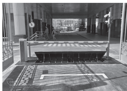
Рис. 2. Вид дорожного блокиратора врезного типа
