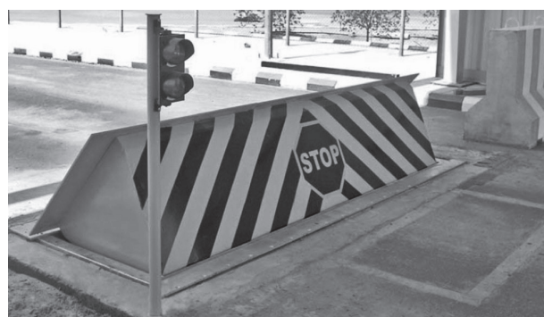
Рис. 3. Вид усиленного дорожного блокиратора врезного типа
