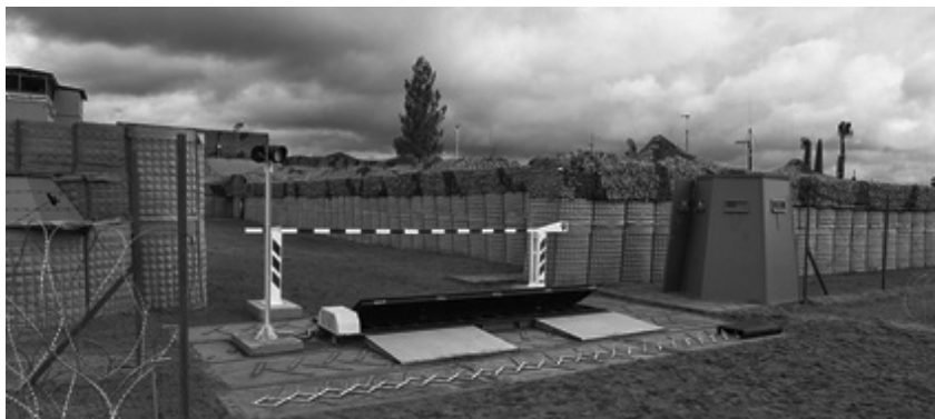
Рис. 1. Пример использования ГНТ для оборудования блок-поста
