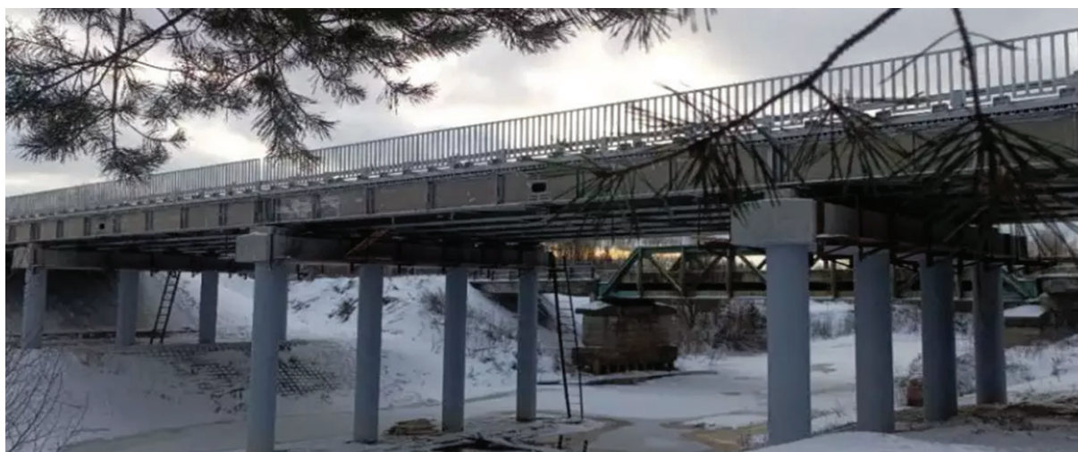
Рис. 4. Вид на мост сбоку, на заднем плане виден старый однополосный стальной мост
