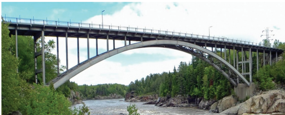
Рис. 1. Мост Arvida Bridge, канадская провинция Квебек, центральный пролет 88,4 м
