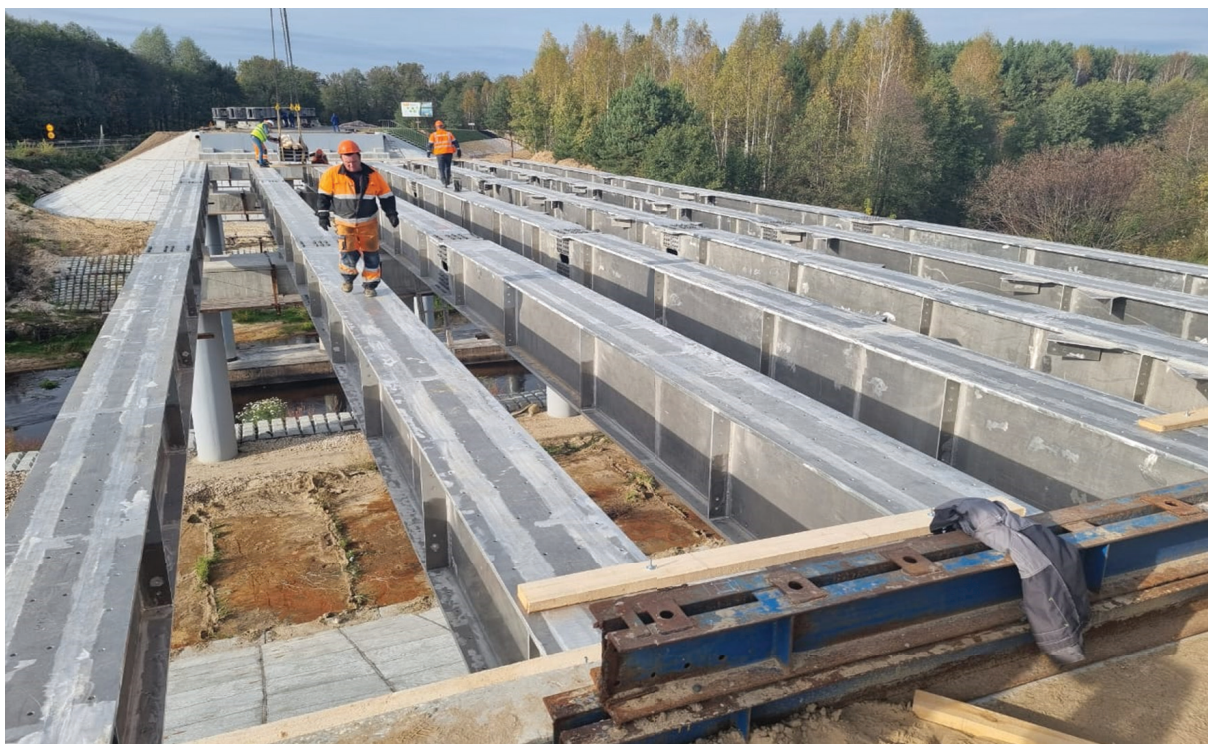
Рис. 18. Установленные несущие балки пролетного строения
