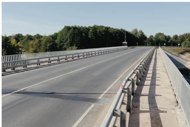
Рис. 3. Вид на мост со стороны обочины двухполосного шоссе
