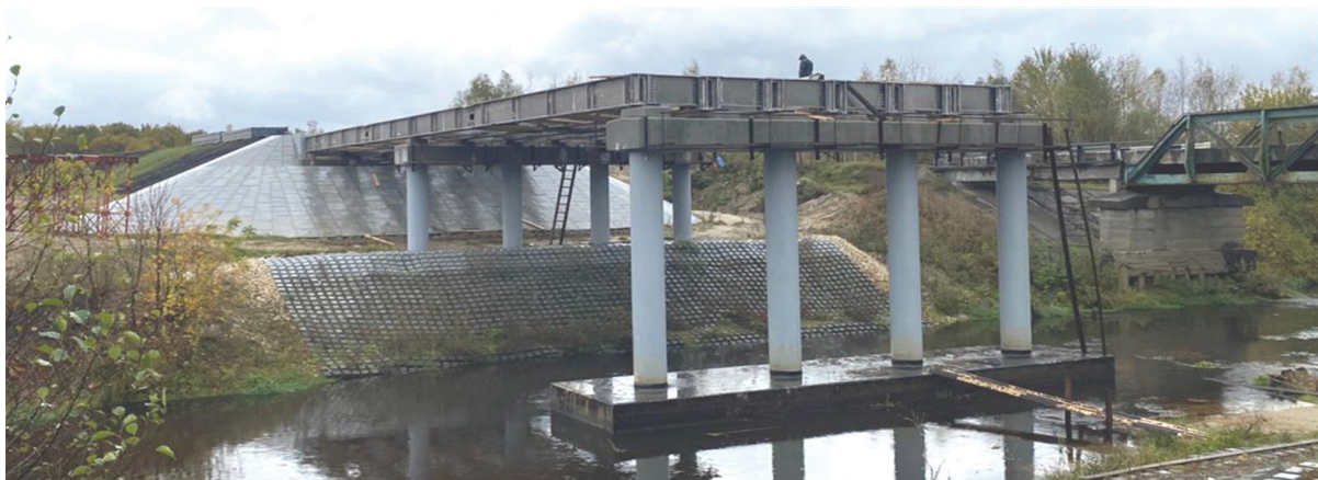
Рис. 17. Установка пролетного строения на железобетонные опоры
