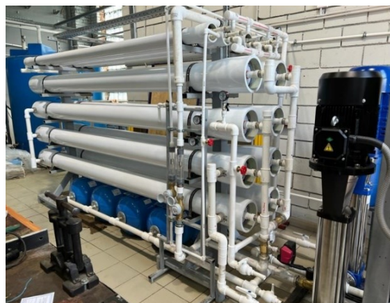
Рис. 4. Мембранные установки, оснащенные мембранами обратного осмоса 8040 и модулями открытого канала 4040 для снижения расхода концентрата и повышения извлечения Fig. 4. Membrane units equipped with 8040 reverse osmosis membranes and 4040 open channel modules to reduce concentrate consumption and increase recovery
