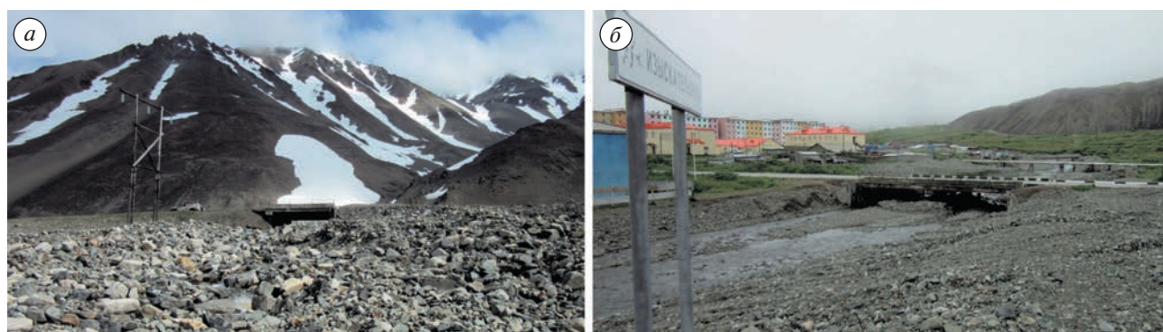
Рис. 3. Селеопасные участки в районе пос. Эгвекино́т: селевые отложения в русле р. Дорожная (а); мост через ручей Изыскательский, частично очищенный от селевых отложений после схода селя 16 октября 2016 г. (б).
