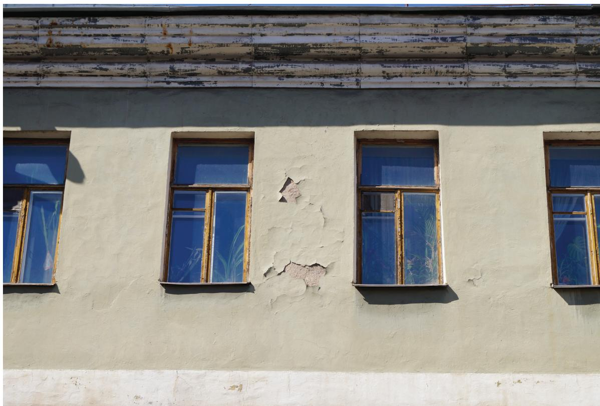
Рис. 1. Разрушение отделочного слоя штукатурного покрытия
