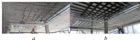
Рис. 7. Здание Омсктехуглерод: a — подготовительные мероприятия перед установкой СВА; b — результаты усиления
