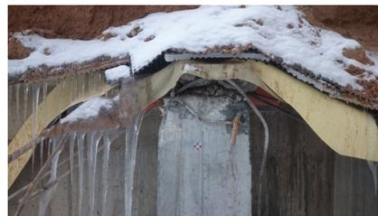
**Рис. 4.** Обрушение покрытия подземной парковки в г. Сергиев Посад, ул. Фестивальная. Опорный узел монолитного покрытия и сборной железобетонной колонны
