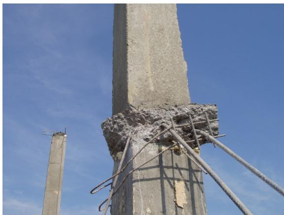
**Рис. 2.** Обрушение строящегося здания МРЭО ГИБДД в г. Коломна, ул. Митяево. Опорный узел перекрытия первого этажа
