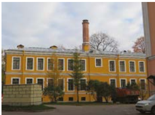
Рис. 1. Здание кафедры фармакологии после капитального ремонта 2015–2017 гг., (2017)
