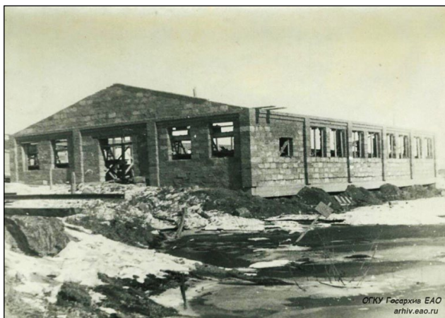
Рис. 1. Строятся цеха завода
