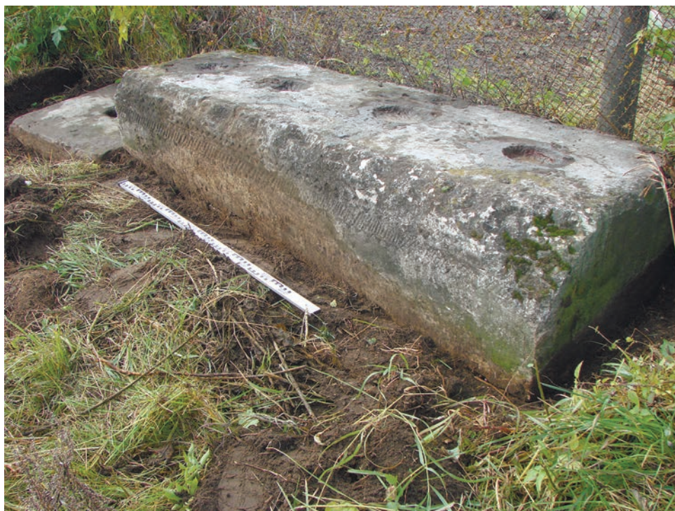
Рис. 3. Две плиты (основная и приставная малая) основания монумента. Фото автора, 2020 г. Fig. 3. Two slabs (the main and attached small ones) of the monument base. Photo by the author, 2020
