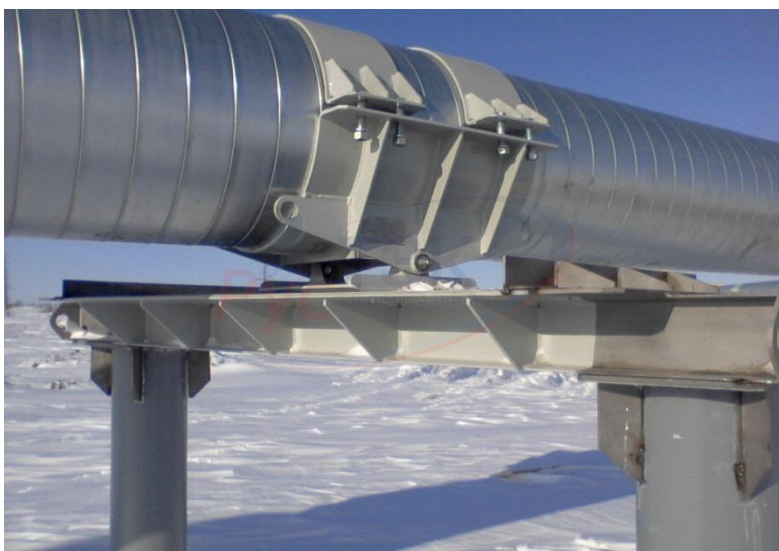
Рис. 7. Подвижные опоры нефтепровода
