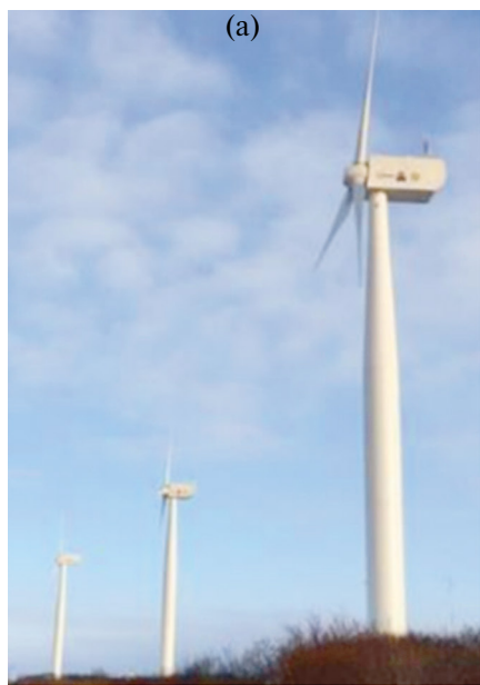
Рис. 5. Ветрогенератор KWT-300 (KOMAI HALTEC Inc.) для суровых климатических условий (а) и кривая мощности KWT-300 (б).
